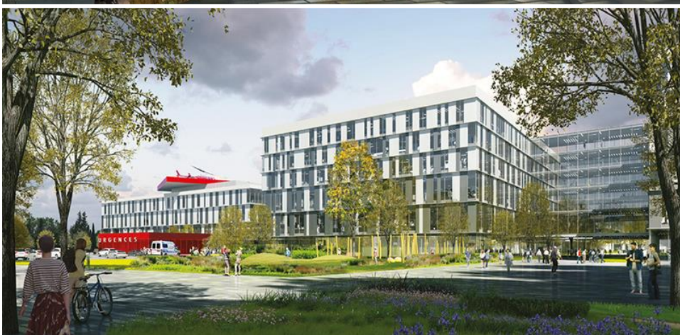
Vue piétonne coté Urgences
